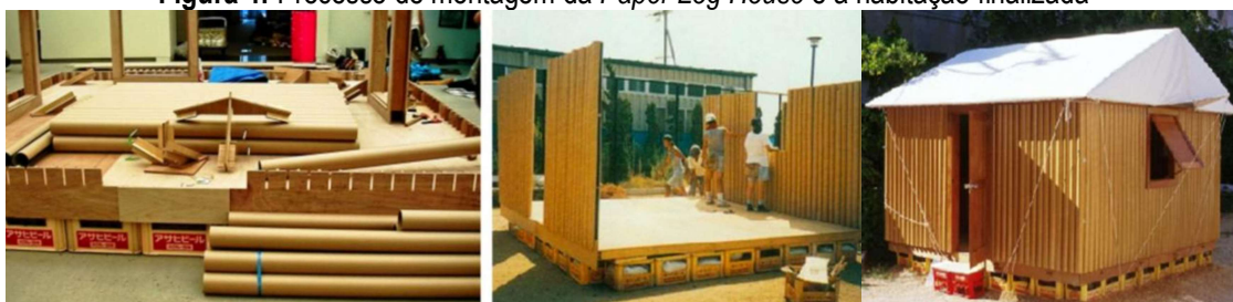
Figura 4: Processo de montagem da Paper Log House e a habitação finalizada
