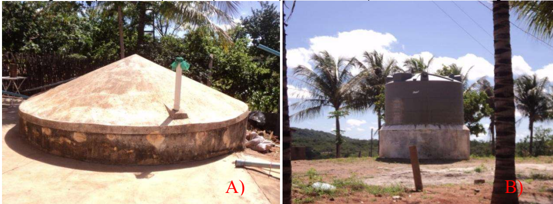
Figura 7: A) Cisterna de placas e B) Cisterna de plástico utilizadas para armazenamento de água.
