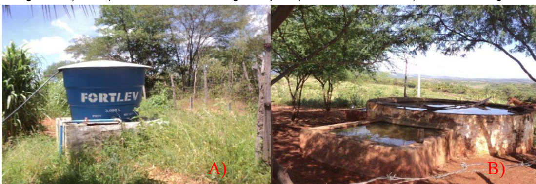
Figura 8: A) Caixa para armazenamento de água e B) Tanques de cimento usados para armazenar água.
